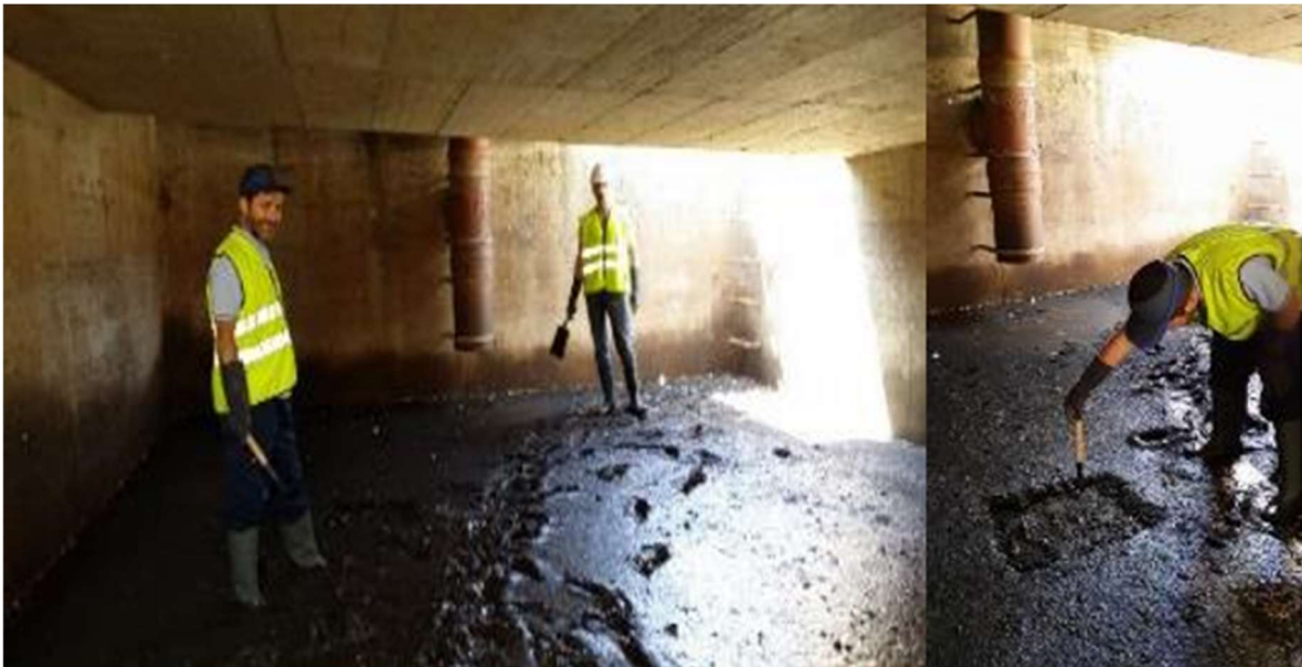
ნახაზი 3. 7 - ფილტრის შიდა ხედი, სადაც აკუმულირებული დანალექი შეინიშნება.
